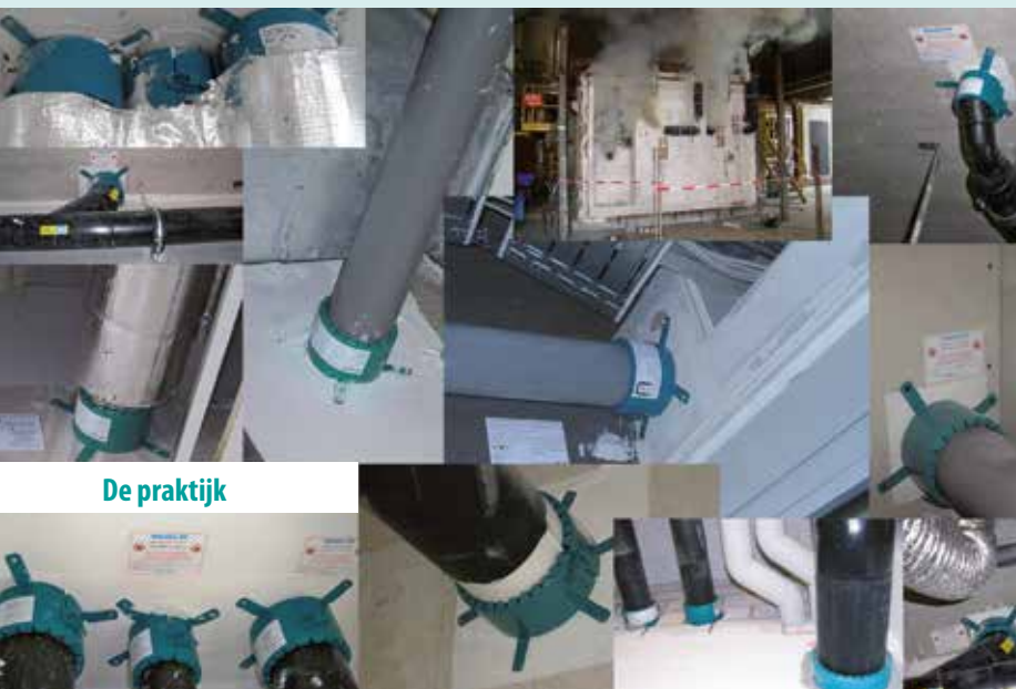
Massieve muur: met Spax Heavy Duty 1-zijdige montage vuurbelastende zijde
